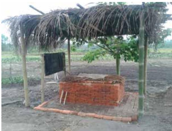
ZECC (Zero energy cool chamber) cámara refrigeradora para mantener fresco el producto cosechado
